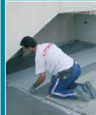
Фото 9. Выравнивание полотна стеклосетки по краю компенсационного шва
