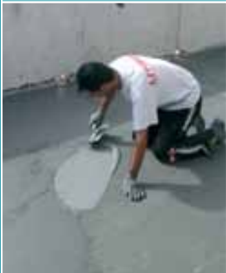
Фото 13. Выравнивание гидроизоляционного слоя ELASTOCEM MONO.
