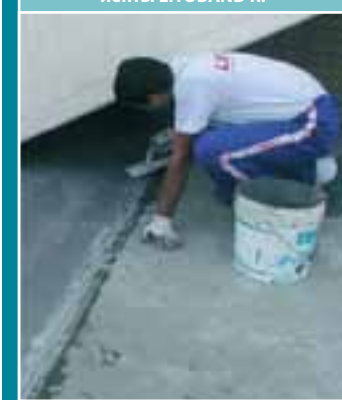
Фото 7. Нанесение ELASTOCEM MONO на края приклеенной ленты LITOBAND R.
