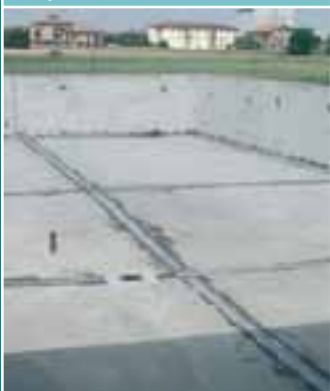
Фото 14. Поверхность террасы с выполненными компенсационными швами и гидроизоляцией ELASTOCEM MONO.
