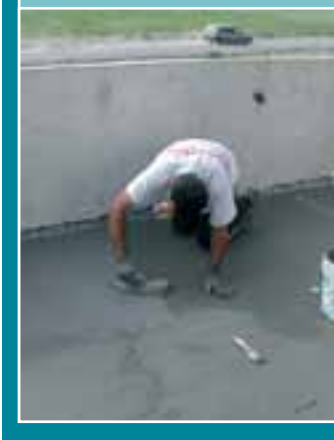
Фото 11. Нанесение 2-го слоя ELASTOCEM MONO по стеклосетке
