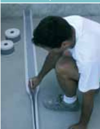
Фото 5. Укладка ленты LITOBAND R в компенсационный шов
