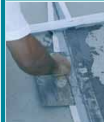
Фото 6. Приклеивание ленты LITOBAND R в зоне компенсационного шва на ELASTOCEM MONO.
