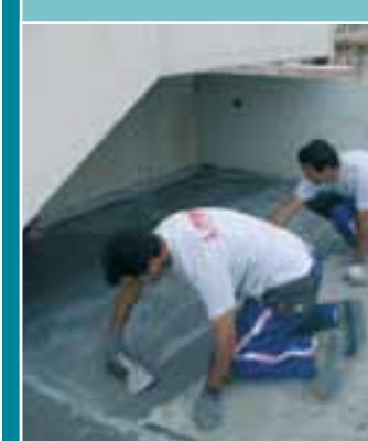
Фото 10. Утапливание стеклосетки в слой ELASTOCEM MONO
