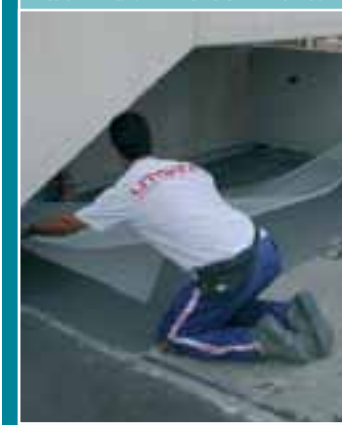
Фото 8. Укладка стеклосетки на свежий слой ELASTOCEM MONO.
