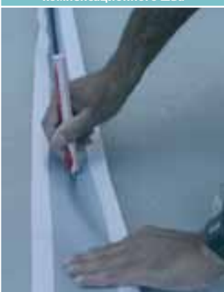
Фото 4. Герметизация компенсационного шва
